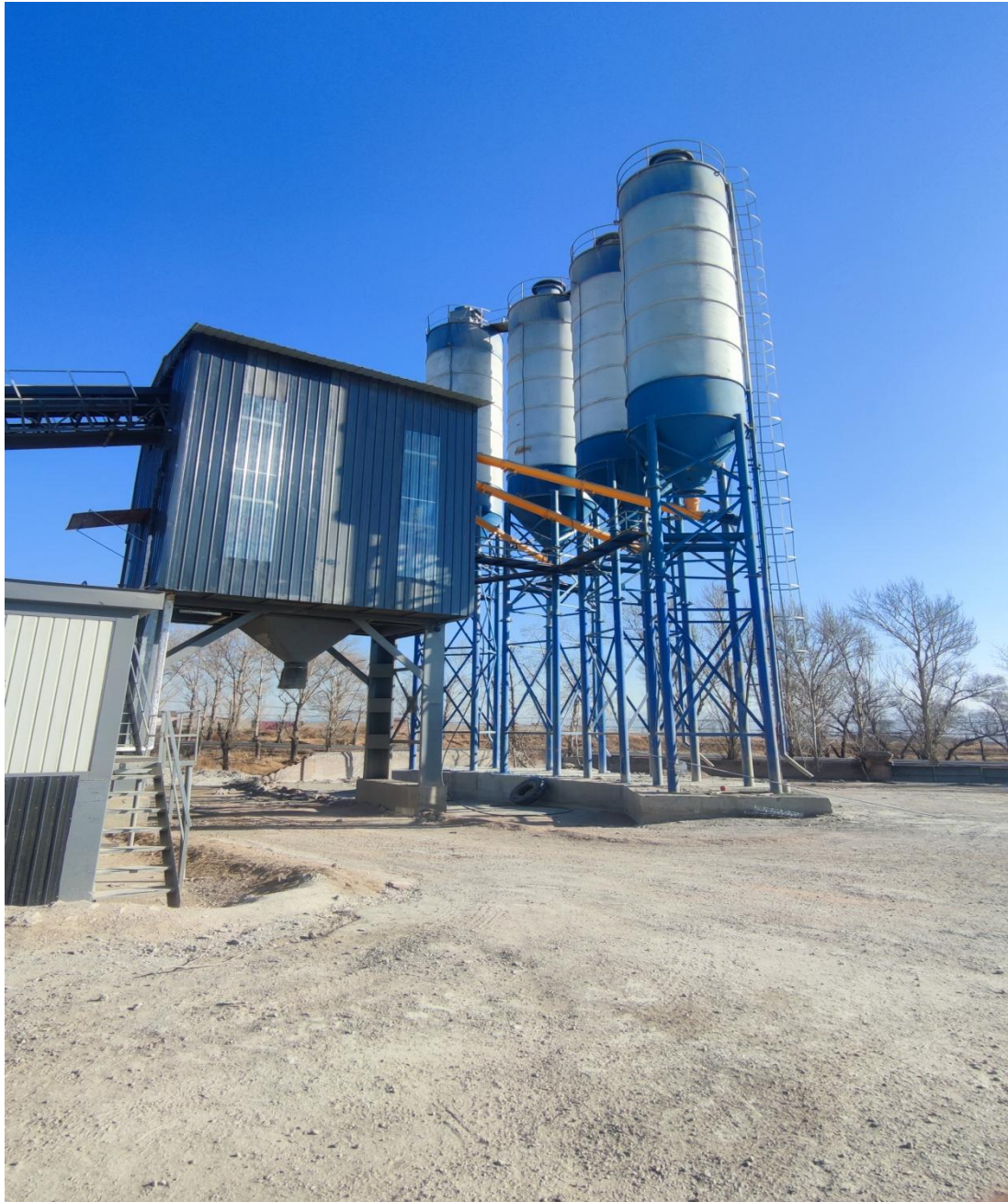
图 3-2 脉冲式除尘器
